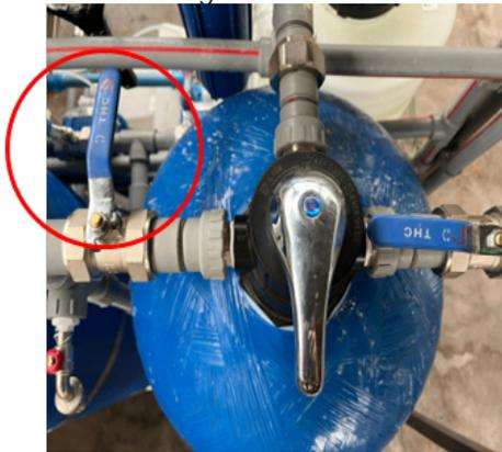
c. Revisar que la descarga de agua este saliendo a través de la tubería de "RECHAZO".
