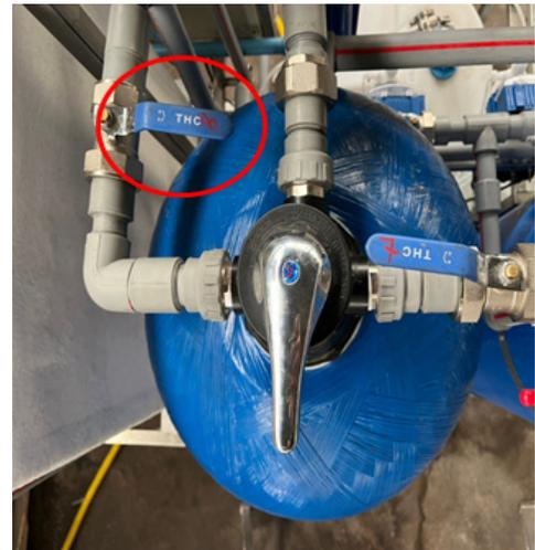
c. Revisar que la descarga de agua este saliendo a través de la tubería de "RECHAZO".
