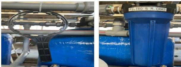
7. Manualmente se debe girar la válvula de tres en la posición para retro lavado. Asegurarse que tenga agua cruda para la limpieza.
